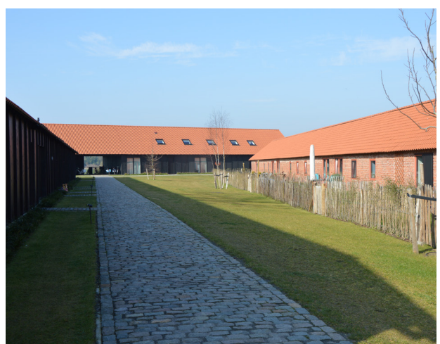
figuur 10 voormalige quarantainestallen
