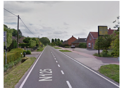
figuur 22 woonlint Moerkantsebaan west (bron. Google Streetview)
