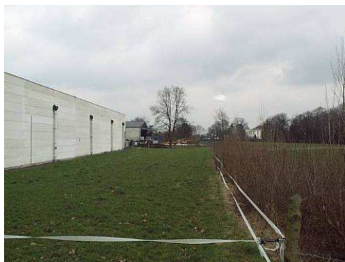
Foto 21: Zicht op de achterzijde van de gebouwen
