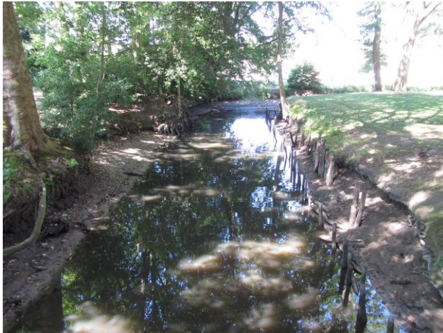
Figuur 22: Geërodeerde oever zuidelijk deel.
