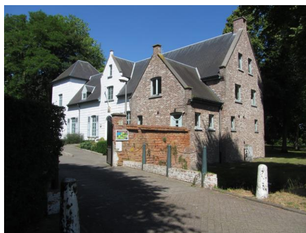
Figuur 11: Hoofdtoegang in oosten.
