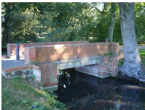
Figuur 17: Brug richting jeugdkalen in westen.
