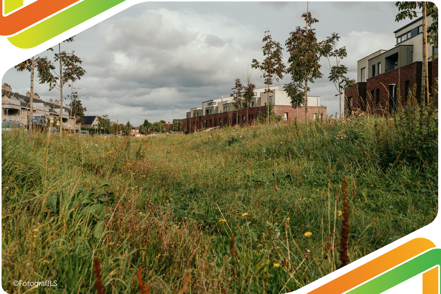
Een grote wadi in Witzenbergstraat buffert regenwater en zorgt voor infiltratie
